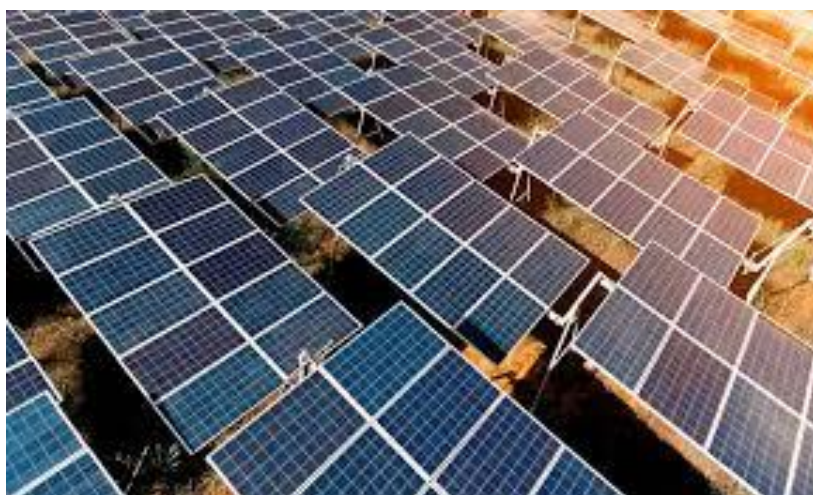
Exempel på fix solcellsuppställning
